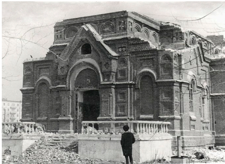
Разрушение Смоленско-Семнозерной церкви
